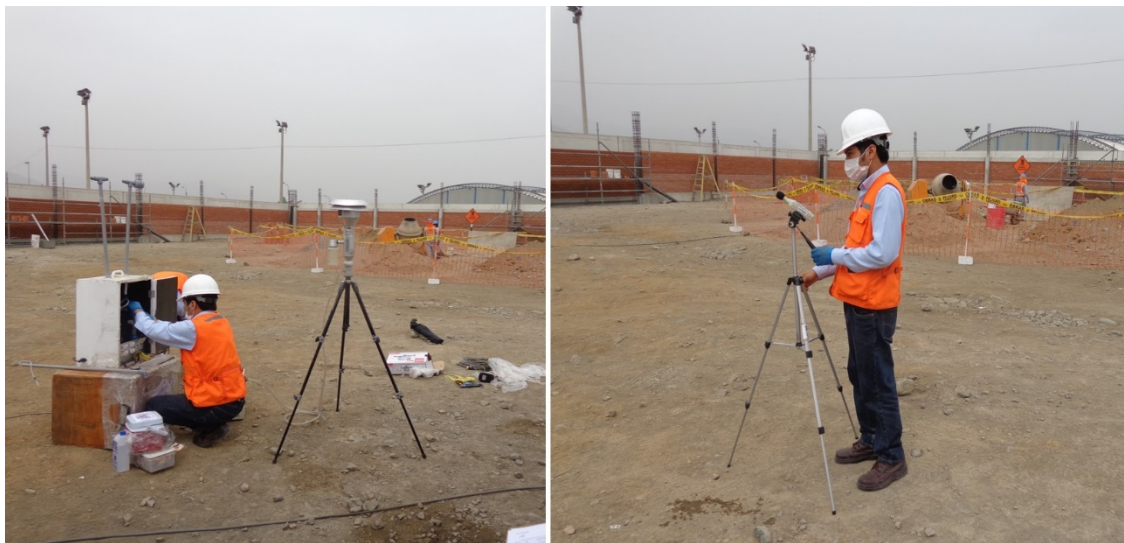
Monitoreo de calidad de aire y ruido – SET Mariátegui en construcción.
