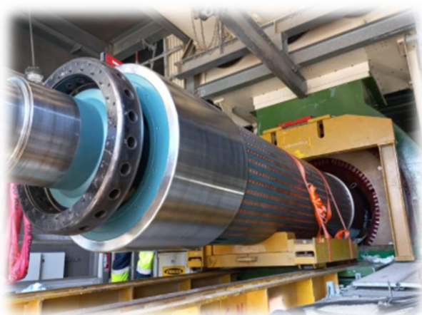
Ingreso de rotor de generador
