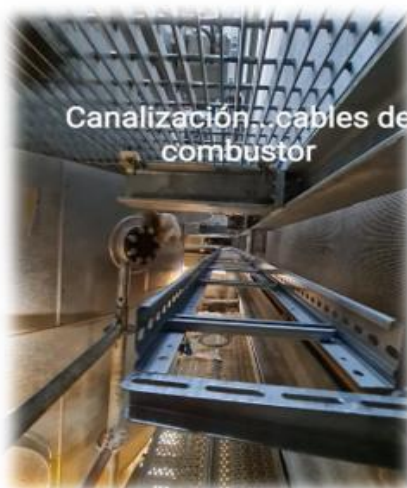
Tendido de cables en interior de encerramiento
