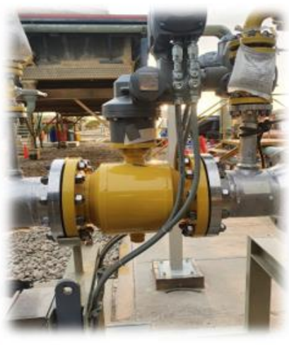
Conexión de nuevos equipos e instrumentos
