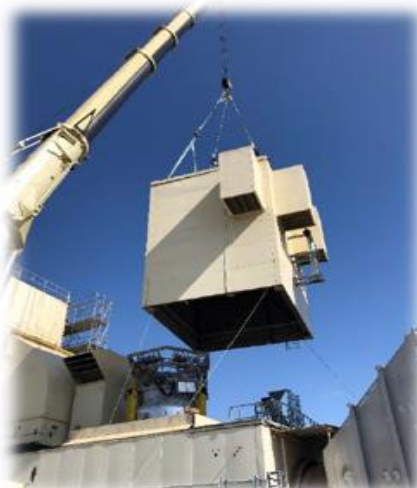
Montaje de encerramiento de combustor
