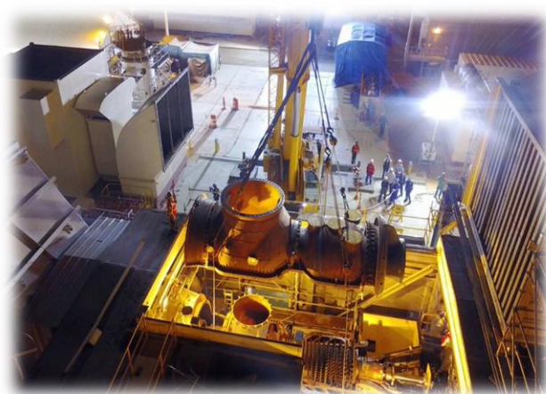
Ingreso de rotor de generador
